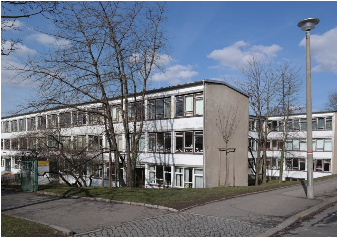
Abb. 4: Abteilung Denkmalschutz und Denkmalpflege im Amt für Kultur und Denkmalschutz Dresden
